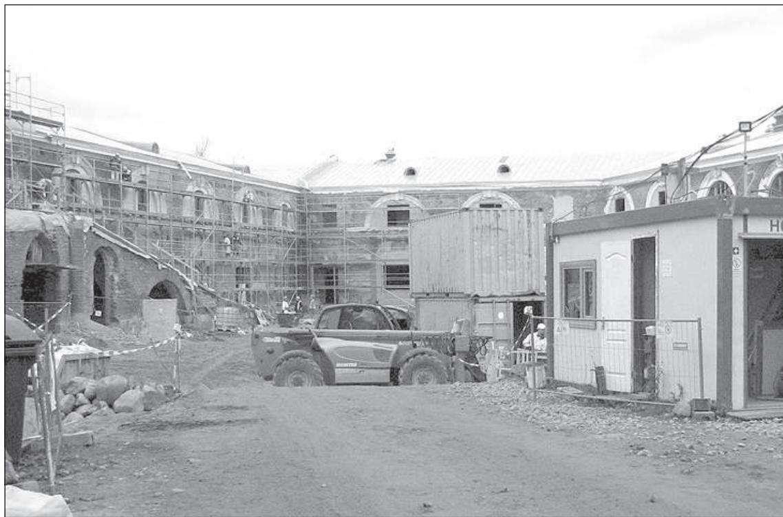
Идут строительные работы.
