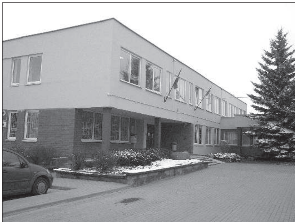
Отремонтирован фасад здания управления волости.
