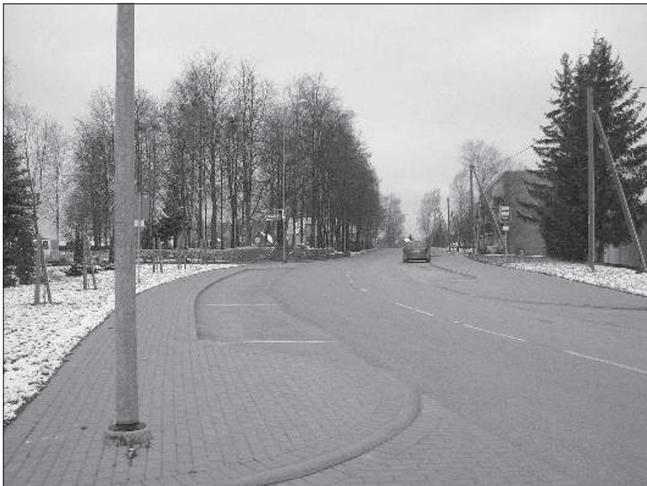
Дороги в поселке Мирный заасфальтированы.
