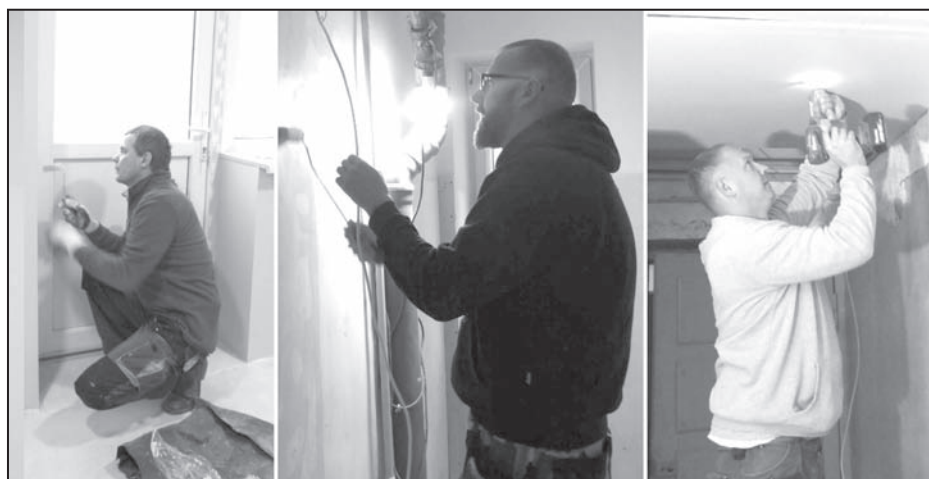
Remontbrigāde rūpīgi veic darbus, lai Aleksandrs varētu ērti dzīvot un integrēties sabiedrībā
