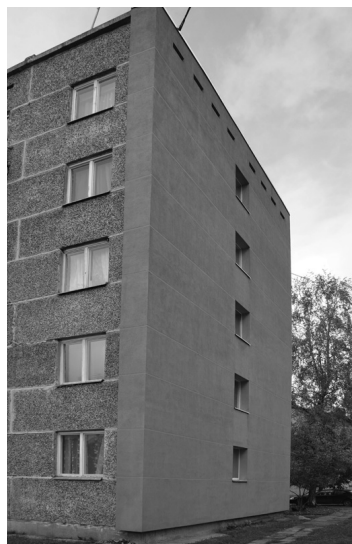
Ēkai Jaunajā ielā 24 nosiltinātas mājas galu sienas
