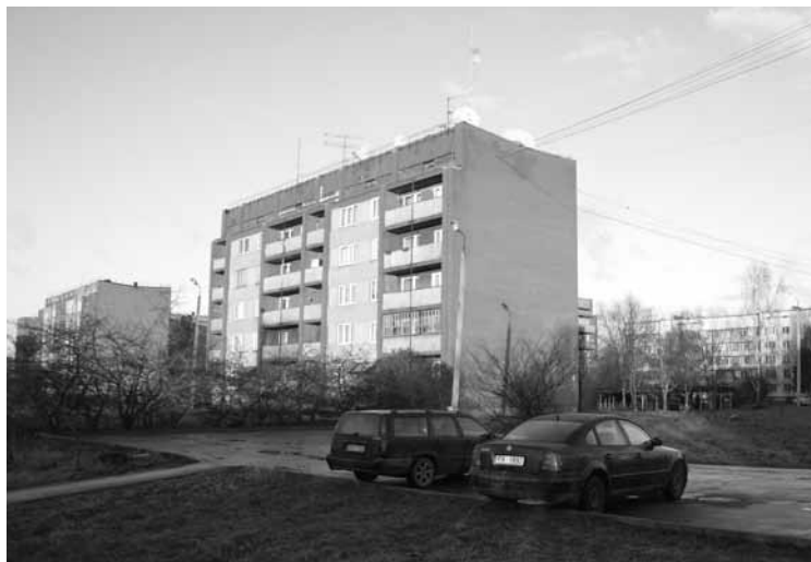
Nākamgad siltumtrašu rekonstrukciju plānots veikt Celtnieku ielas mikrorajonā
