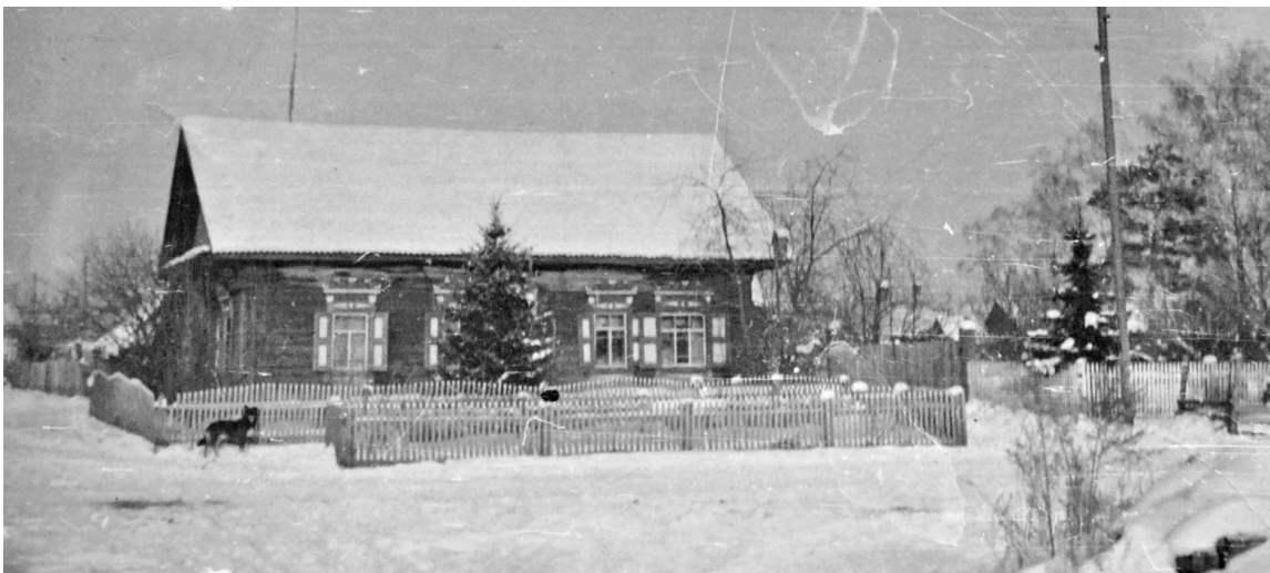
Baubeļu - Kalniņu māja Lejas Bulānā // Foto no V. Kalniņa archīva
