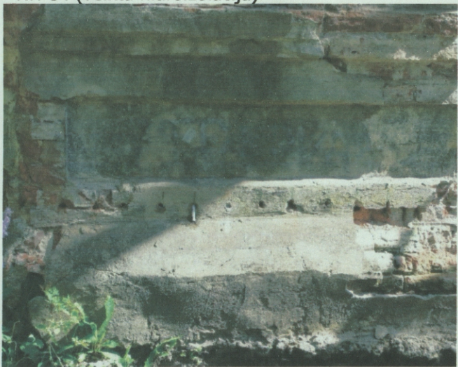
Nr. 84 (veikta hidroizolācija)
