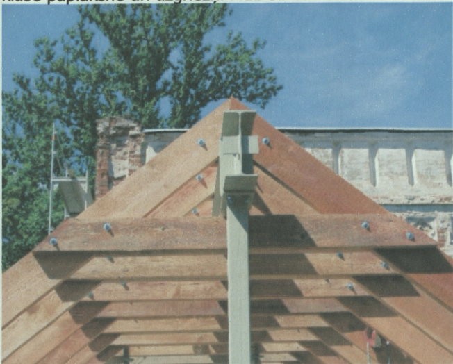
Nr. 48 jumta koptura velmēta profila IPE 300 un koka saišķa 100x150h mm montāža ass 9-12, vītņstienis M12 8.8 klase paplāksne un uzgriežņi M12 SB ISO 4032
