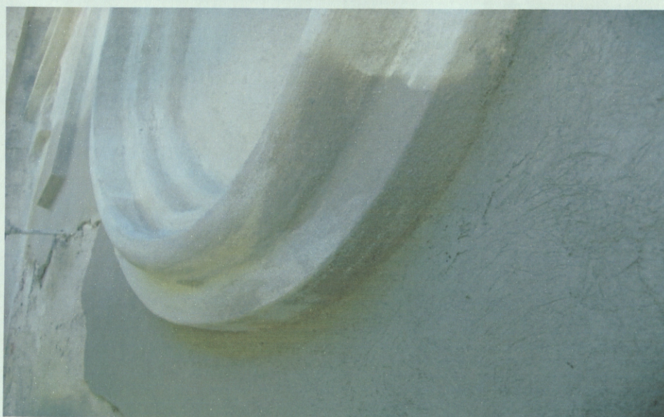
Foto Nr. 63 - Z puse asīs 4-7 ovālo medaljonu apakšējā profilējuma dalās remonts.
