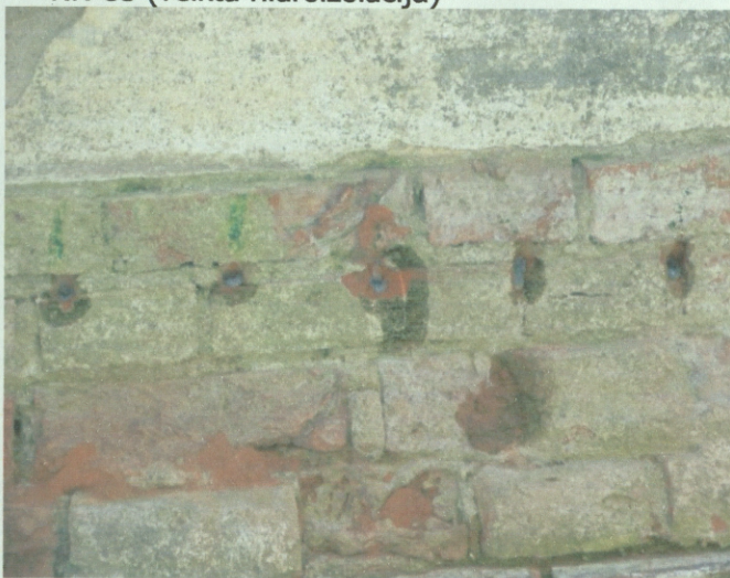
Nr. 85 (veikta hidroizolācija)
