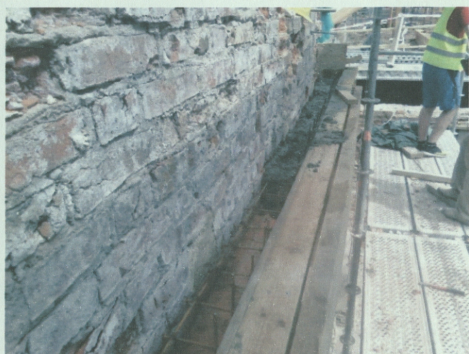
Nr. 4 ( asis 10-11, redzams mūrlatas atbalsta vietas armējums un betonēšana ) Nr.5
