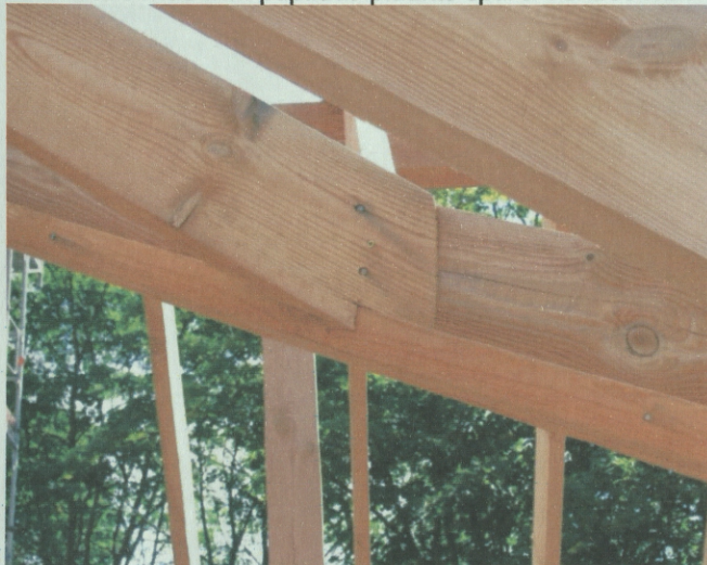
Nr. 47 spāru galu savienojums, koka kores sija 120x200h mm izveidots iegriezums statnim. Vītņstienis M12 8.8 klase paplāksne un uzgriežņi M12 SB ISO 4032
