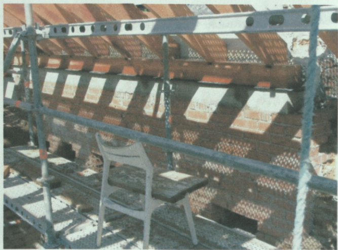
Nr. 8, 9 ( sienas apmetums, mūrlas atbalsta vietas betonējums un mūrlatas montāža pabeigta asis 10-11 )
