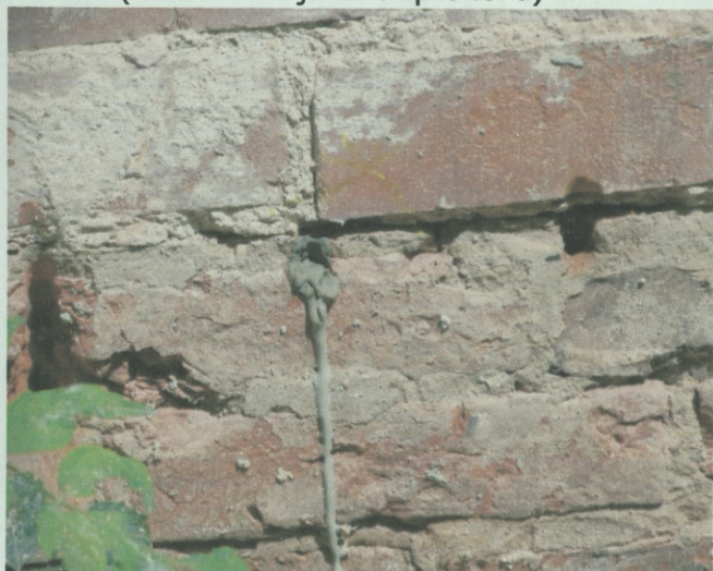
Nr. 84 (veikta hidroizolācija)
