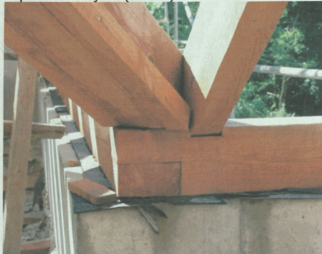
Nr. 47 spāru galu savienojums, koka kores sija 120x200h mm izveidots iegriezums statnim. Vītņstienis M12 8.8 klase paplāksne un uzgriežņi M12 SB ISO 4032
