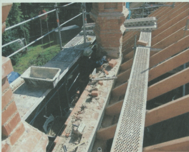
Nr. 30 ( no jumta puses ass 11-10)
