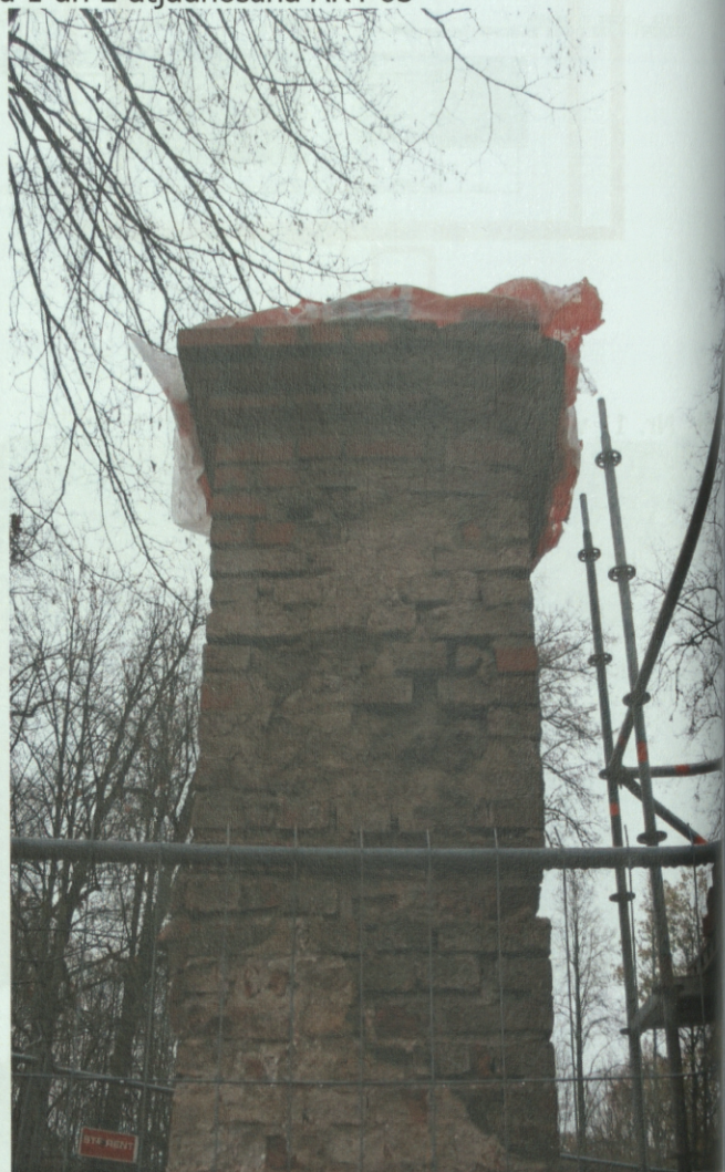
Attēls Nr. 17 un 18 vārtu stabu mūrēšanu un profilu 1 un 2 atjaunošana AR4-03
