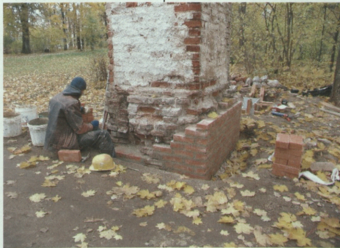
Attēls Nr. 12 vārtu staba protezēšana
