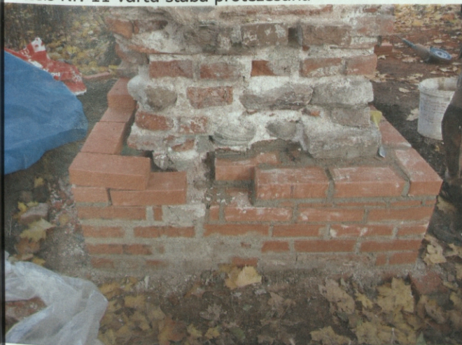
Attēls Nr. 13 vārtu staba protezēšana pabeigta
