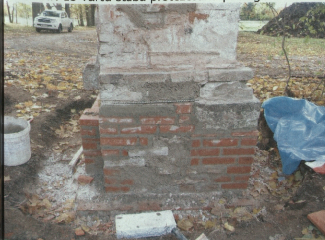
Attēls Nr. 15 vārtu stabu galvu mūrēšana.
