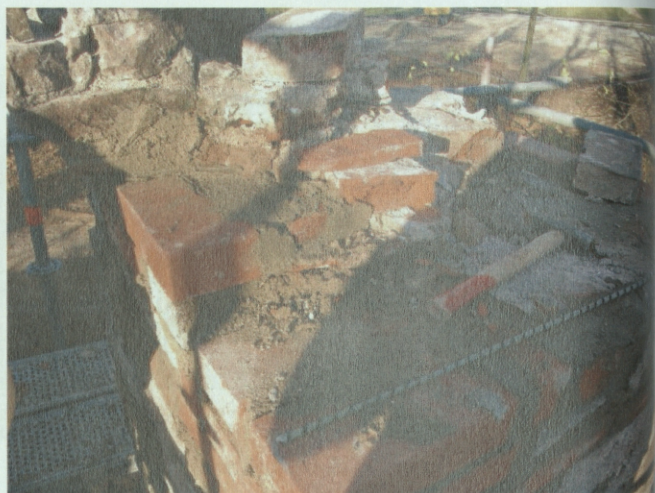
Attēls Nr. 17 un 18 vārtu stabu mūrēšanu un profilu 1 un 2 atjaunošana AR4-03
