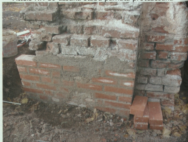
Attēls Nr. 10 uzsākti stabu pamata protezēšana
