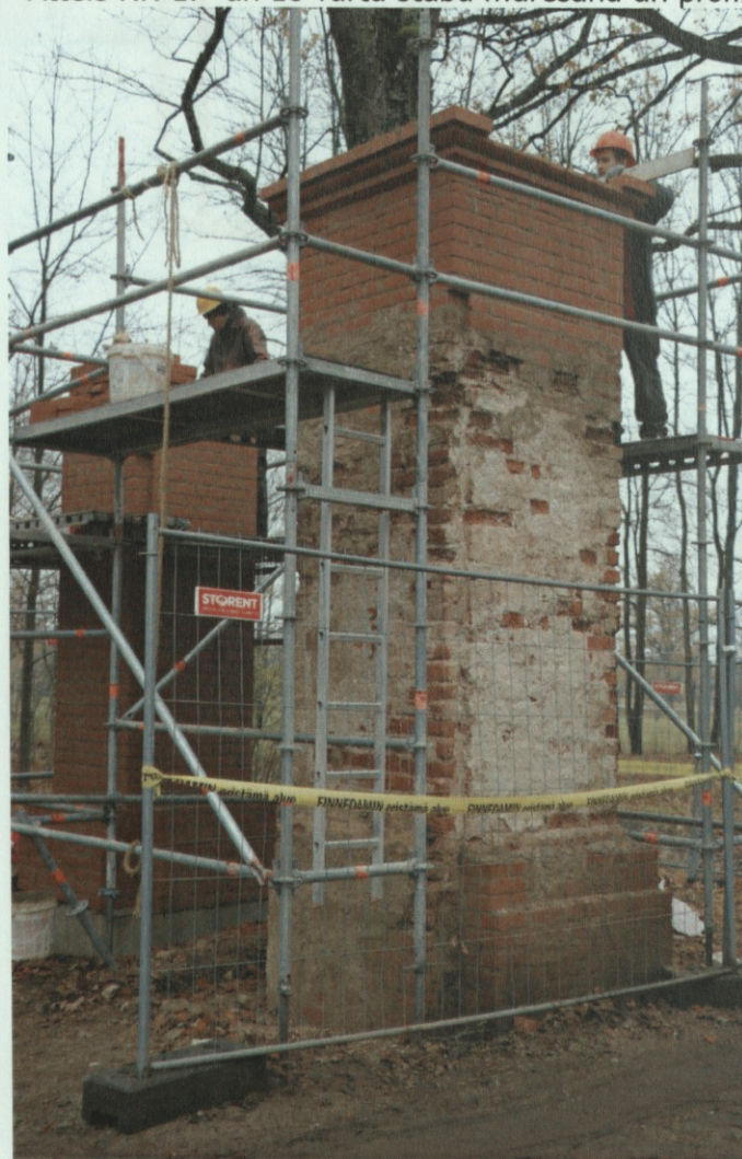
Attēls Nr. 17 un 18 vārtu stabu mūrēšanu un profilu 1 un 2 atjaunošana AR4-03
