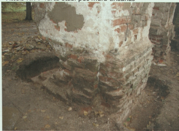
Attēls Nr. 9 uzsākti stabu pamata protezēšana
