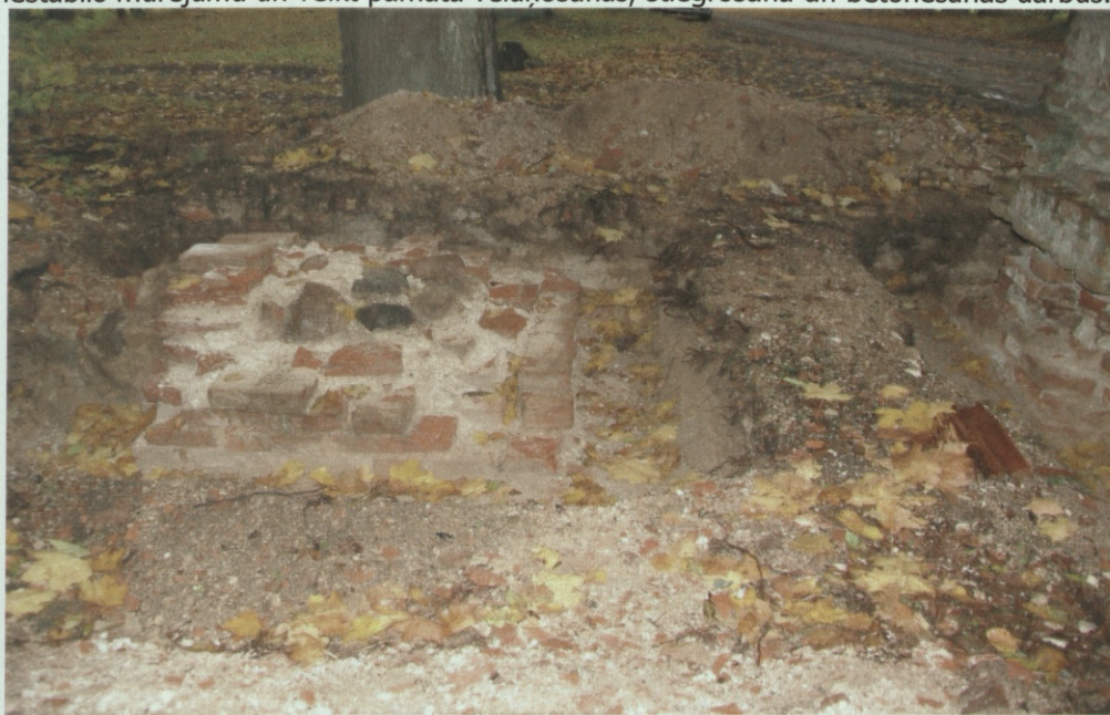
Attēls Nr. 4 un 5. Pamata izbūve. Armatūras stiegras divās kārtās D=10 mm acs 150x150 mm, betons C20/25 0.6 m3. Hidroizolācijas mastika Den Bit-D, Bītuma membrāna Tehnoelast K-M3.
