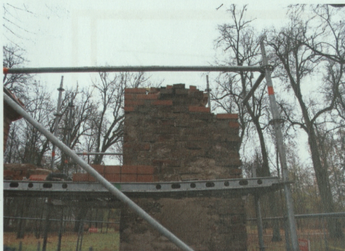
Attēls Nr. 17 un 18 vārtu stabu mūrēšanu un profilu 1 un 2 atjaunošana AR4-03
