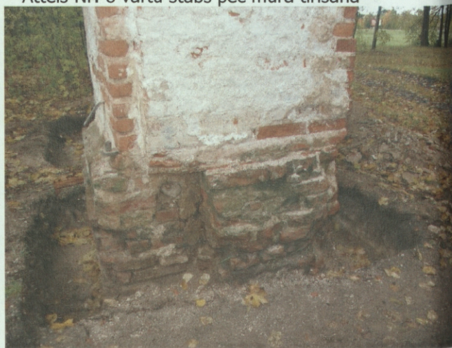
Attēls Nr. 10 uzsākti stabu pamata protezēšana
