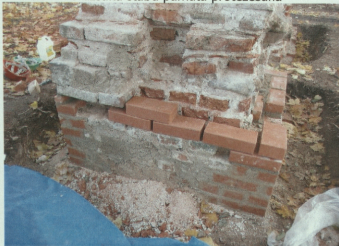
Attēls Nr. 9 uzsākti stabu pamata protezēšana
