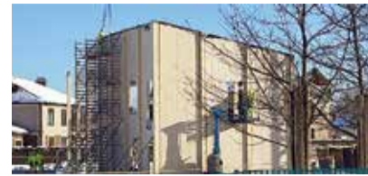
Salaspils septītā pirmsskolas izglītības iestāde iegūst būvobjektu.
