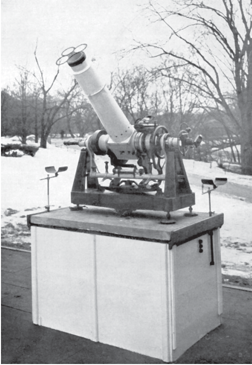
7. att. LU AO Laika dienesta vajadzībām iegādātais Gustava Heides firmas lielais pasāžinstruments.
