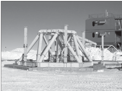
7. att. Dienvidpola 10 metru teleskopa SPT pamats 2004. gada 28. decembrī.
