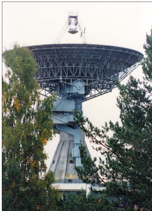
1. att. Topošā VSRC 32 m diametra paraboliskās antenas kopskats 1994. gada septembra beigās.
