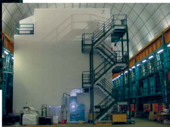
2. att. Gran Sasso laboratorija. Tūneli zem kalna atrodas laboratorija, kuru kalns ekranē no kosmiskā starojuma.
