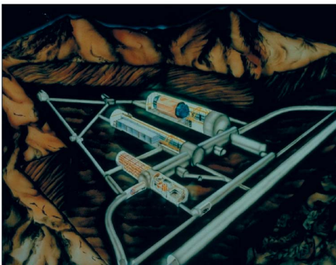
2. att. Gran Sasso laboratorija. Tūneli zem kalna atrodas laboratorija, kuru kalns ekranē no kosmiskā starojuma.
