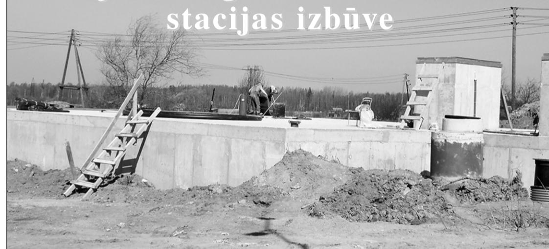
23. maijā ekspluatācijai tiks nodotas rekonstruētās ūdens atdzelžošanas iekārtas. Sobrīd notiek beidzamie darbi pie jaunā ūdens rezervuāra, intensīvi notiek teritorijas labiekārtošana, kā arī turpinās iekārtu regulācija. Tā kā jaunajā ūdens atdzelžošanas stacijā ir uzstādītas modernas iekārtas, tāpēc šobrīd notiek arī apkalpojošā personā-
