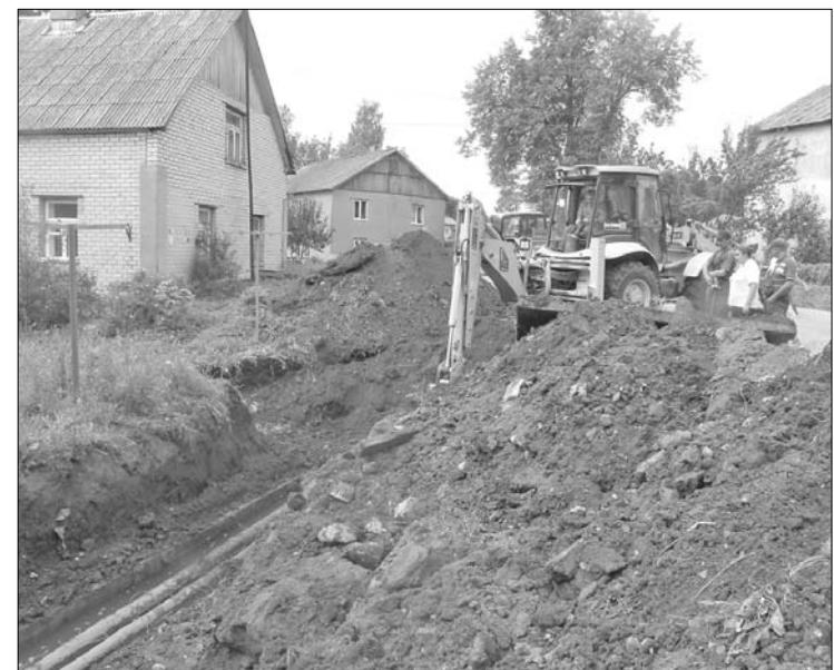
metāla caurules bija kļuvušas plānas kā papīrs, kas apstiprināja SIA «Preiļu saimnieks» speciālistu bāžas, par to, ka tās jebkurā brīdi varēja plīst. Šī siltumtrases izveidota pirms vairāk kā 30 gadiem un šo gadu laikā tā nav tikusi rekonstruktēta, līdz ar to gan pašas caurules, gan to siltumizolāciju jau sen ir savu nokalpojušas.
