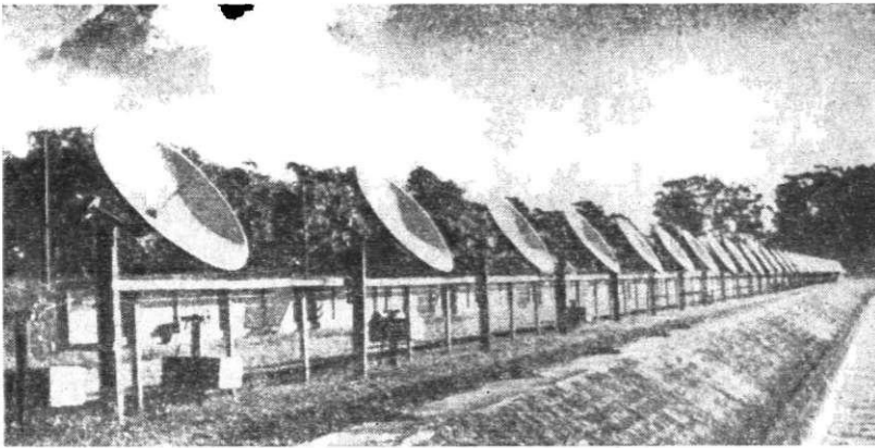
27. att. Kristiansena radiointerferometrs radioastronomiskajā observatorijā pie Sidnejas (Austrālija). Tas sastāv no 32 paraboliskiem reflektoriem, kas novietoti vienādos attālumos viens no otra. Bāzes garums — 214 m.
