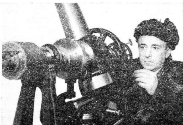
2. att. Laika dienesta mazais firmas «Askania Werke» pasāžinstruments, ar ko līdz 1959. gada beigām veikti novērojumi vecajā novērošanas paviljonā. Pie instrumenta prof. K. Steins.
