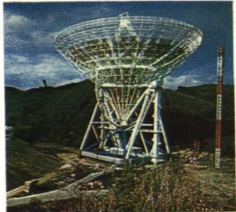
Pasaulē lielākā visos virzienos grozāmā radioteleskopa antena — Bonnas Maksa Planka Radioastronomijas institūta 100 m diametra paraboloīds.
