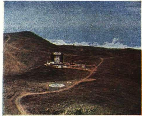
Lielbritānijas-Nīderlandes 15 m radioteleskops milimetru viļņu diapazonam Maunakea. Paviljons un radioteleskops tiek pagriezti sinhroni.
