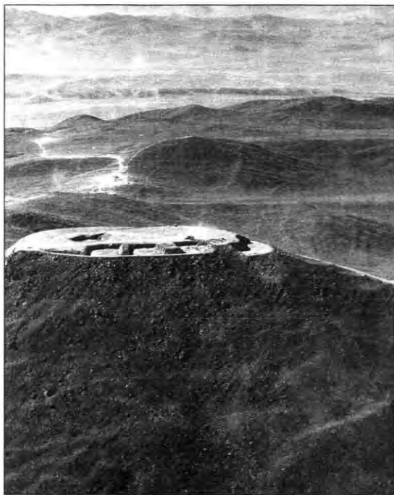
1. att. 1993. gada beigās Paranalā kalnā (Čīle) virsotnē strādā tehnika, gatavojot pamatu ESO milzu teleskopam VLT . Labi saskatāmi četri padziļinājumi, kur tiks izbūvēti kupoli lielajiem spoguļiem. Tālumā redzamas Kordiljeru kalnu grēdas.
