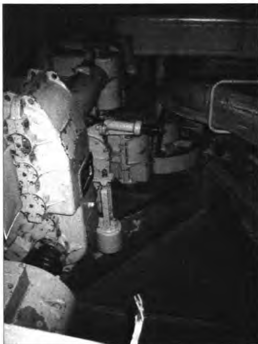
16 m antenas leņķiskā augstuma piedziņas sistēma remonta laikā.
