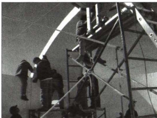
Jumta paneļu montāža.
