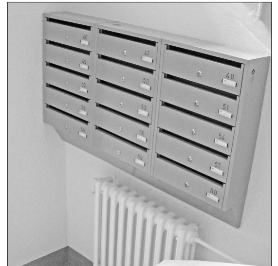
Значительные ремонтные работы этим летом проходят в жилом доме по улице А. Упиша 3. Отремонтированы вторая и четвертая лестничные клетки, для которых жители выбрали приятный лимонно-желтый цвет и декоративную штукатурку. На лестничных площадках установлены новые почтовые ящики (на снимке) и заменены радиаторы отопления, поставлены новые ПВХ окна, а также новые входные двери.
