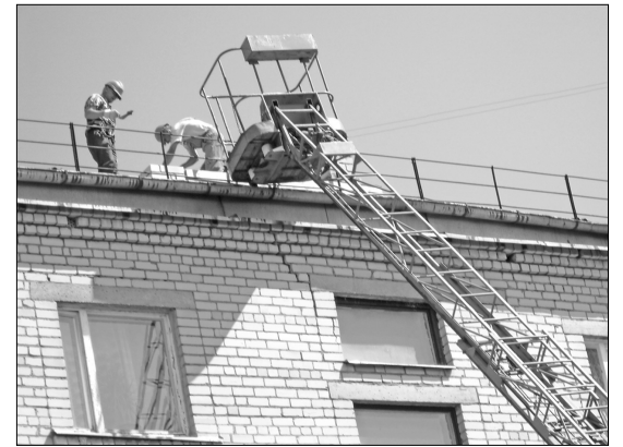
На снимке: в доме по улице Ранцана 1 отремонтированы вентиляционные трубы.
