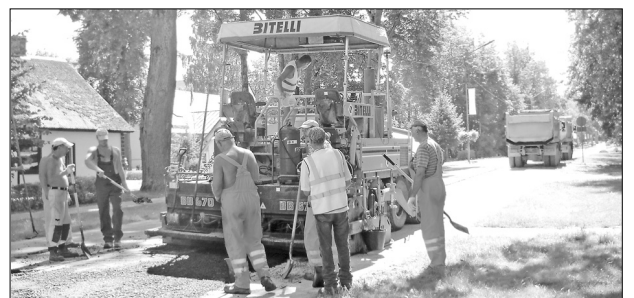
На многих улицах, где закончено строительство подземных коммуникаций, восстановлено асфальтобетонное покрытие. На снимке: укладка асфальта на бульваре Райниса.
