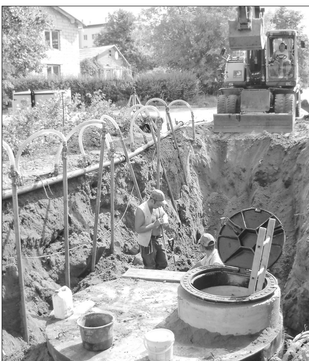
Attēlā apakšzemes komunikāciju ierīkošanas būvdarbi A.Upīša ielā. Plānots, ka rakšanas darbi šeit turpināsies visu augustu.
