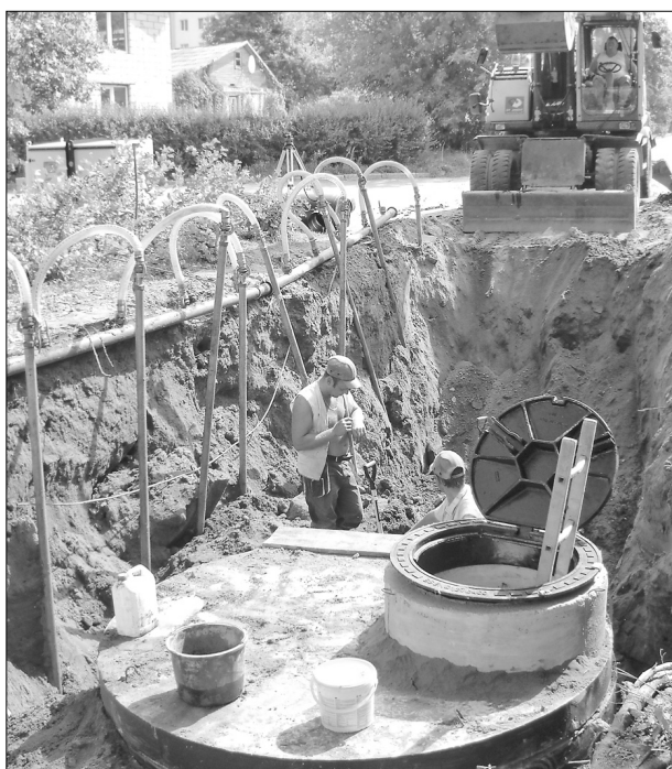
На снимке: на улице А. Упиша проводятся работы по строительству подземных коммуникаций. Планируется, что земляные работы тут будут продолжаться весь август.
