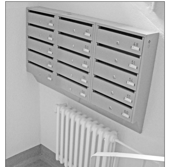
Ievērojami remontdarbi šovasar notiek daudzdzīvokļu dzīvojamajā mājā A. Upīša ielā 3. Izremontēta otrā un ceturrtā kāpņutelpa, kurai iedzīvotāji izvēlējušies patīkamu citrondzeltenu toni un dekoratīvo apmetumu. Kāpņutelpās uzstādītas jaunas pastkastītes (attēlā) un nomainīti radiatori, ielikti jauni PVC logi, kā arī jaunas ārdurvis.
