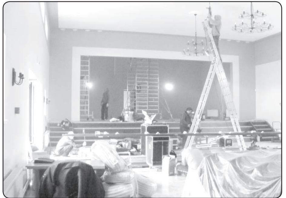
Rit skatuves un apgaismojuma aprīkojuma uzstādīšanas darbi, kas tiek veikti LEADER projekta ietvaros
