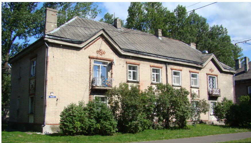
8. att. Divstāvu daudzdzīvokļu dzīvojamās mājas ar izteiktu četrslīpju jumtu.
