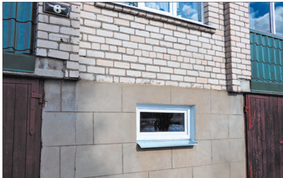
A. Upīša ielas 6 pagrabtelpā uzstādīts PVC logs
