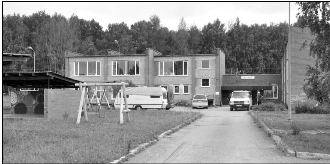
Izveidotajā Variešu sākumskolā šobrīd intensīvi rit renovācijas darbi. Sākumskolas audzēkņiem Krustpils novads nodrošinās bezmaksas transportu nokļūšanai uz skolu un atpakaļ uz mājām, kā arī bezmaksas pusdienas.
