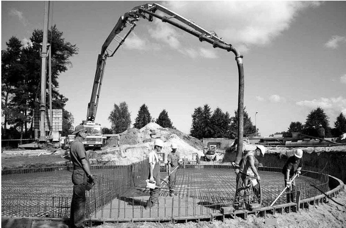
Betonēšana. Foto: Zane Siliņa
