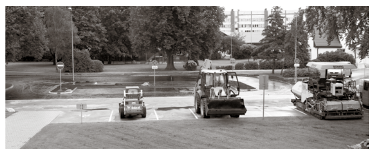
Autostāvvietas izbūve Piņķos, Centra ielā, turpinās (I. Aizsila foto)
