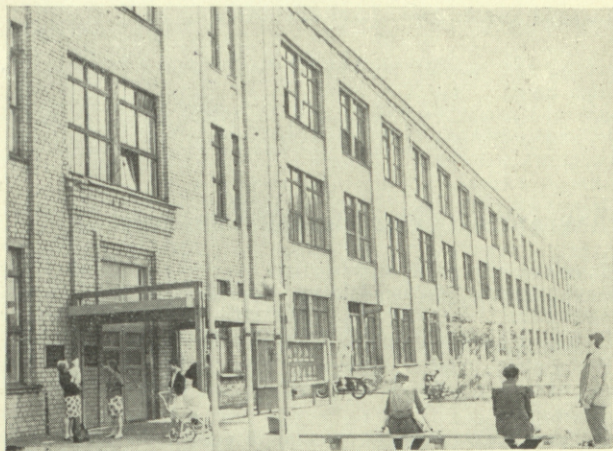
Kombiņāta galvenais korpuss.
