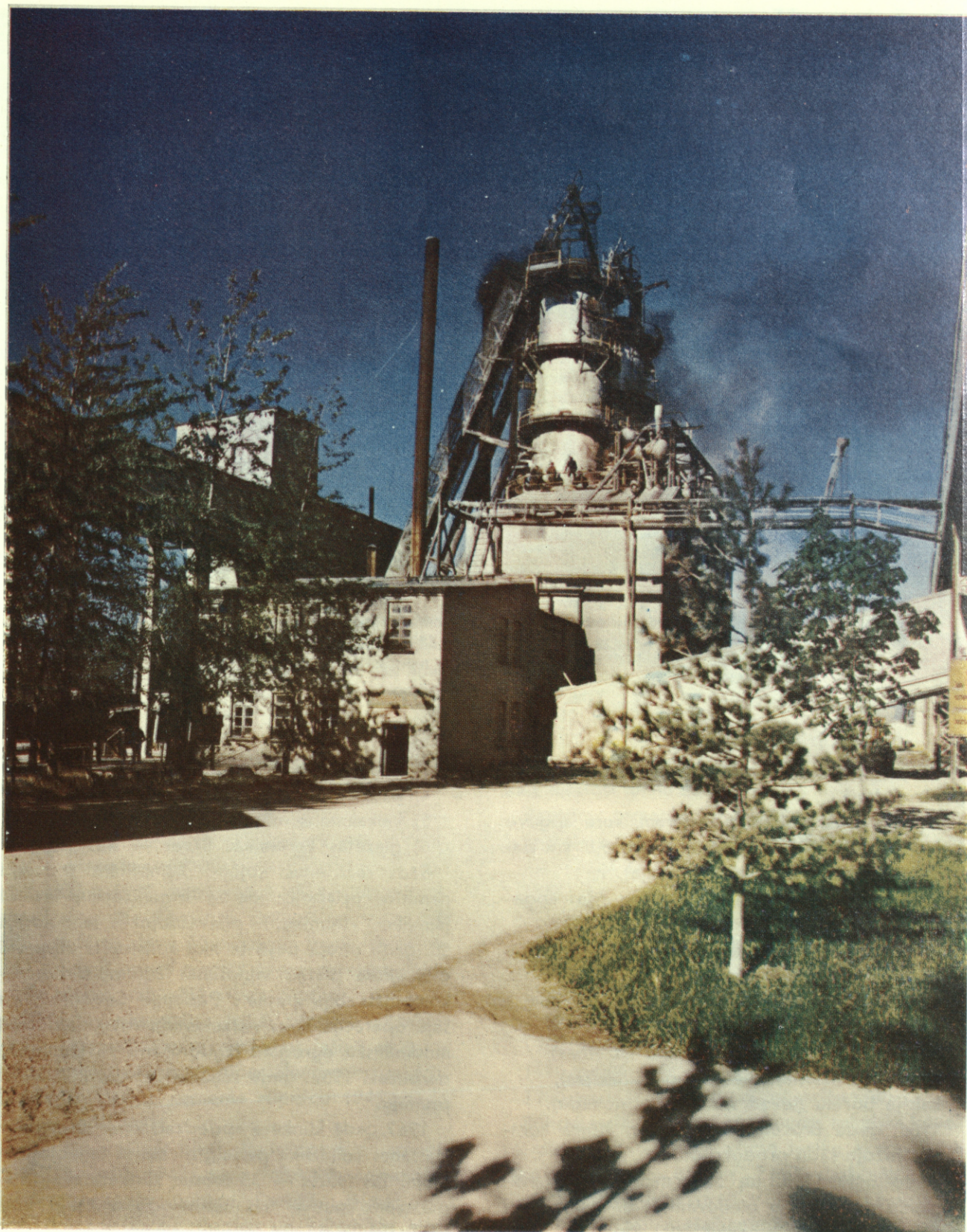
Kaļķu apdedzināšanas krāsnis kalnrūpniecības un kaļķu ceļā Печи обжига извести в горно-известковом цехе The lime burning kilns in the mining and lime shop
