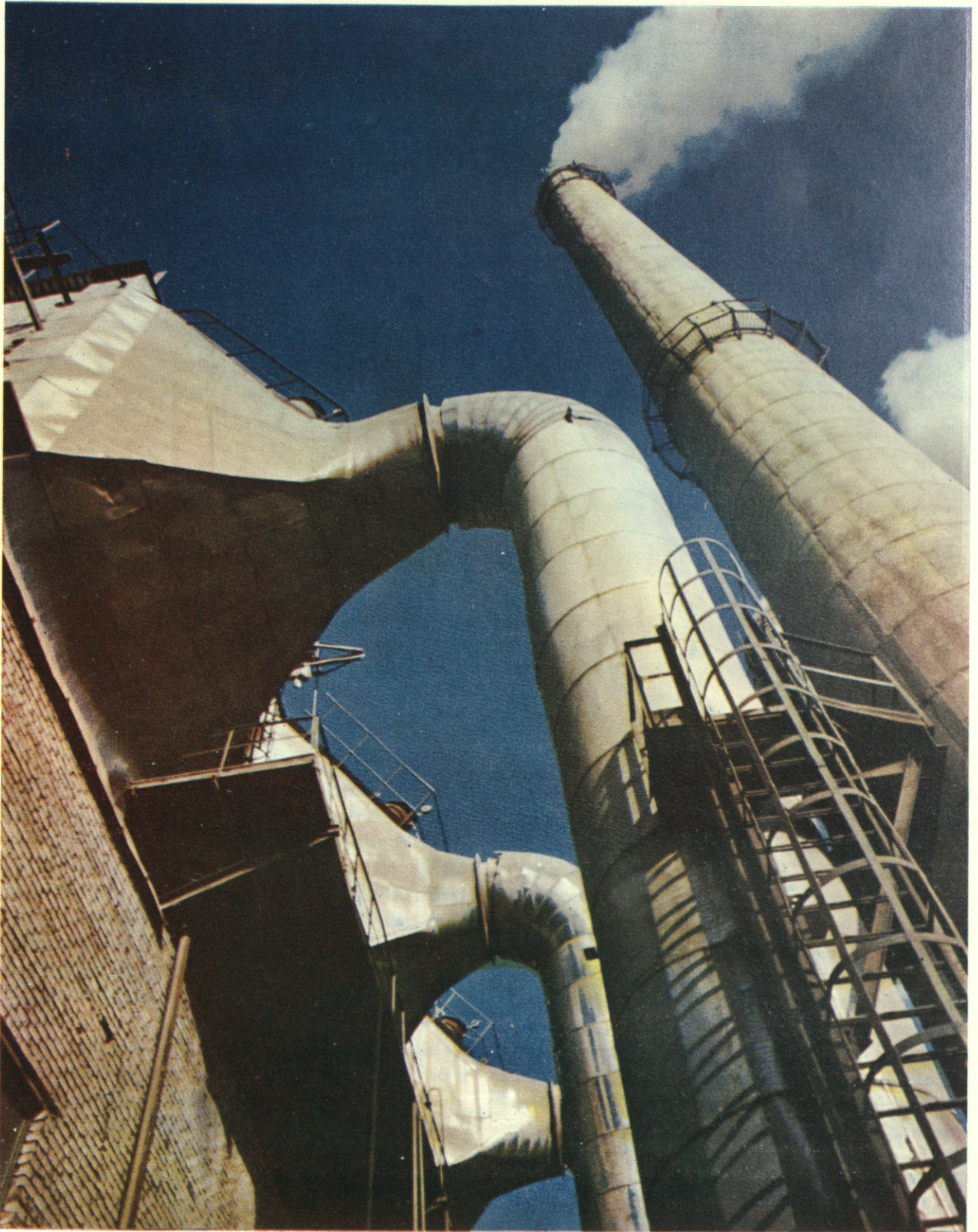
Klinkera apdedzināšanas krāšņu elektrofiltri Электрофильтры печей обжига клинкера The electrofilters of the clinker burning kilns
