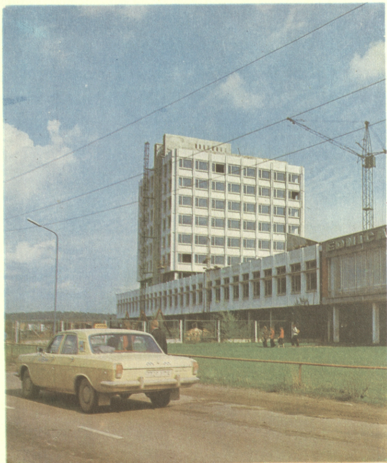
Административно-лабораторный корпус завода РАФ. г. Елгава, ул. Авиацияс, 18
