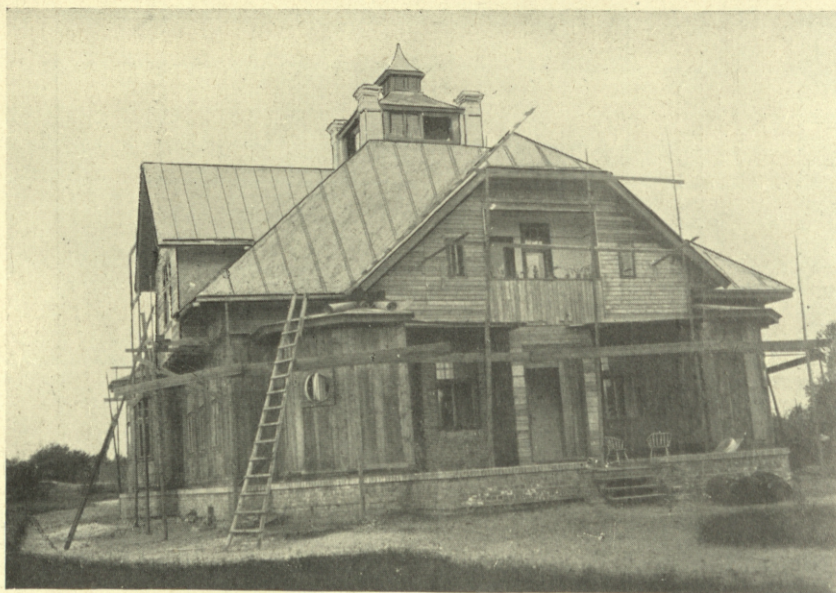
Dzīvojamā ēka Rīgā, Kalnciema ielā, apm. 450 kv. metru jumta laukums iesegts ar Ruberoidu .
