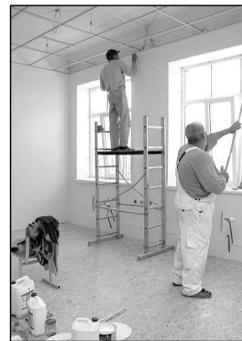
В помещениях общественного центра скоро закончатся ремонтные работы и будет установлено приобретённое в рамках проекта оборудование.
