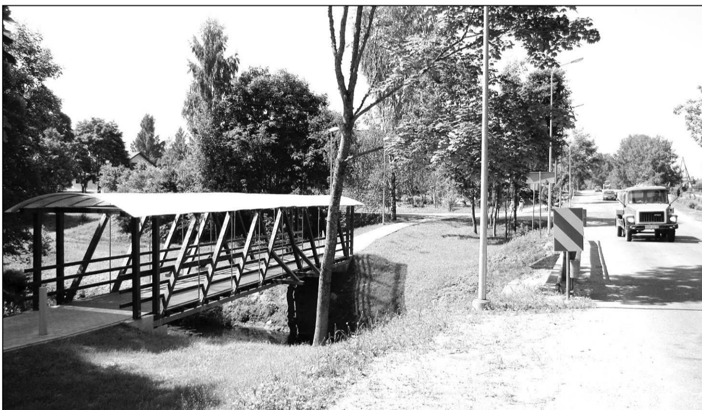
Сейчас жителям посёлка Риебини для того, чтобы перейти через реку Фейманку, не нужно передвигаться по проезжей части дороги, потому что в рамках проекта построен красивый и надёжный мост для пешеходов.
