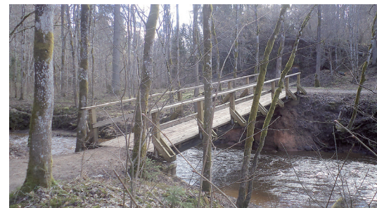
Tiltiņš pāri Līgatnes upei ceļā uz rehabilitācijas centru „Ligatne”, 2021. gada 1. aprīlis. Rasmus Vanagas foto.
