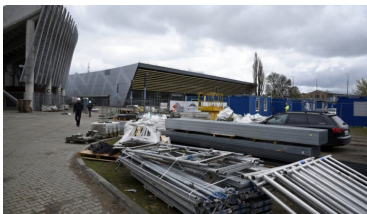
Daugavas stadiona treniņu halle būvniecības procesā 8. maijā
