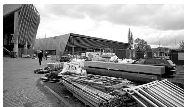
Daugavas stadiona treniņu halle būvniecības procesā 8. maijā
