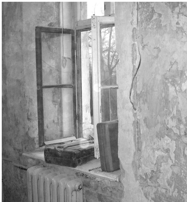
Šobrīd remontējamajā telpā apmetums tiek ņemts nost arī no sienām, līdz ar to skatam paveras pils sienas ar ķieģeļu apdari un tā laika celtniecības īpatnības
