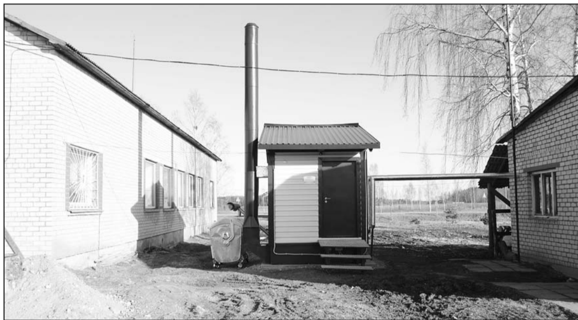
Новая котельная контейнерного типа установлена между бывшей котельной и Силюкалнским домом культуры.
