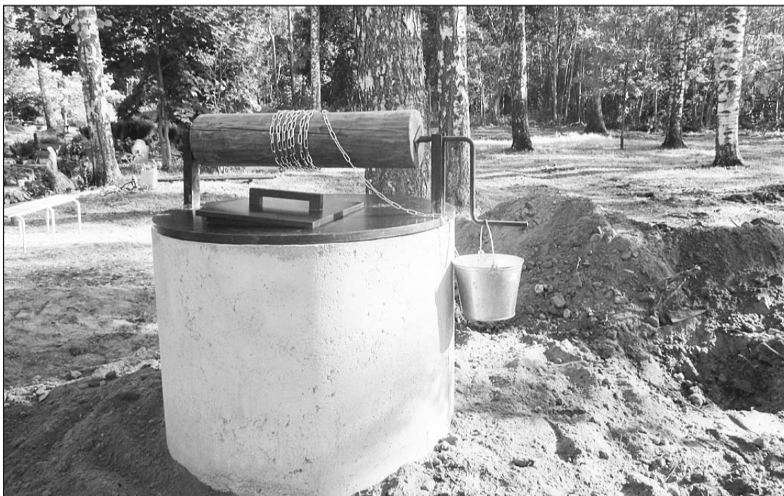
В рамках проекта изготовлены 20 табличек с названиями кладбищ, установлены 16 туалетов, возведены 2 забора и построено 5 колодцев.
