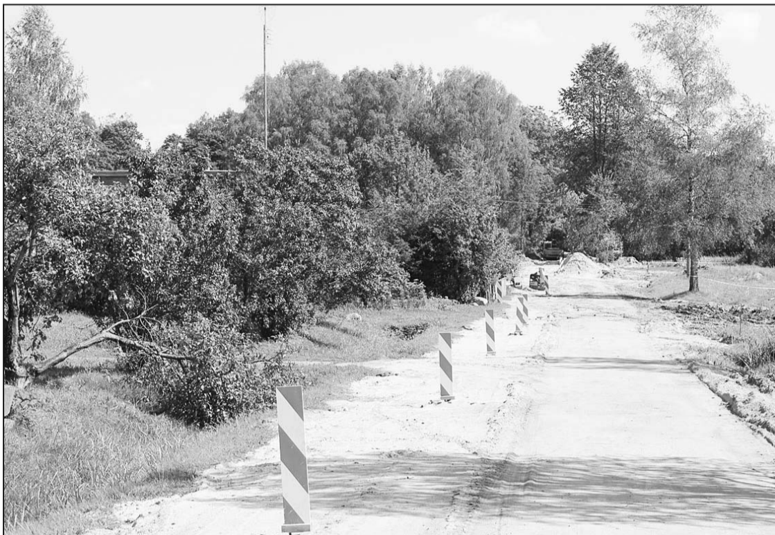
Projekta "Ūdenssaimniecības attīstība Riebiņu novada Riebiņu ciemā II kārtā" ietvaros būvdarbi uzsākti Riebiņu ciemata Skolas ielā.
