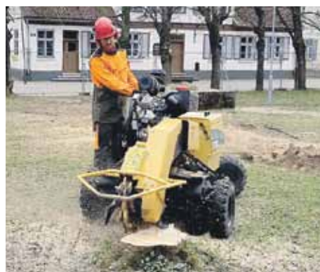
Celmu frēzēšana Kalpaka ielā Kuldīgā blakus topošajai Mākslas akadēmijas filiālei pagājušajā pavasarī. Tas ir efektīvs veids, kā atbrīvoties no celmiem. Rezultāts ir pilnīgi līdzena zemes virskārta.
