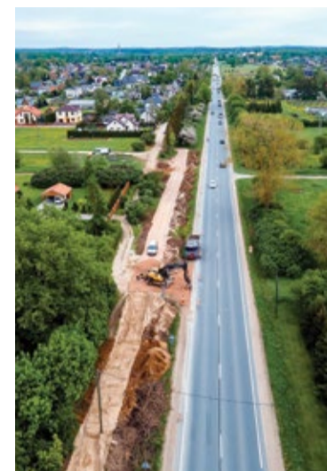
Veloceliņa gar autoceļu A7 pirmā posma izbūve Ķekavā.
