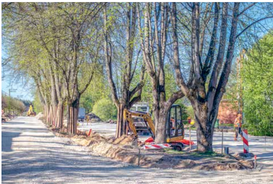
Lai posmā pie dzelzceļa stacijas saglabātu kokus, tiek izbūvētas atsevišķas vienvirziena joslas ap tiem
