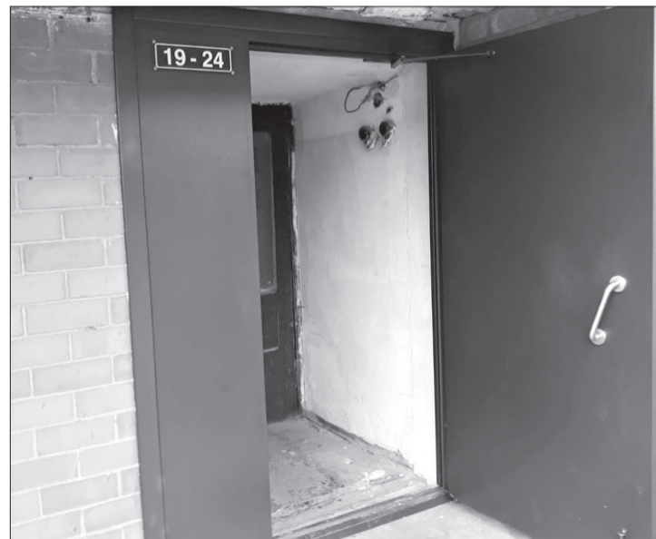
Užavā un Zūrās daudzdzīvokļu mājās uzstādītas jaunas ārdurvis. DIĀNAS SKUDRAS ARHĪVA FOTO
