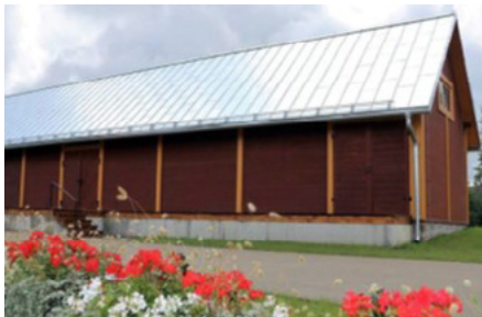
Fig. 7.6. External appearance (Gada labākā būve Latvijā 2018, 2019. The best building of the year in Latvia, 2019).
