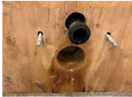
Fig. 3.53. Leaks (Byggeskadefonden, 2020).
