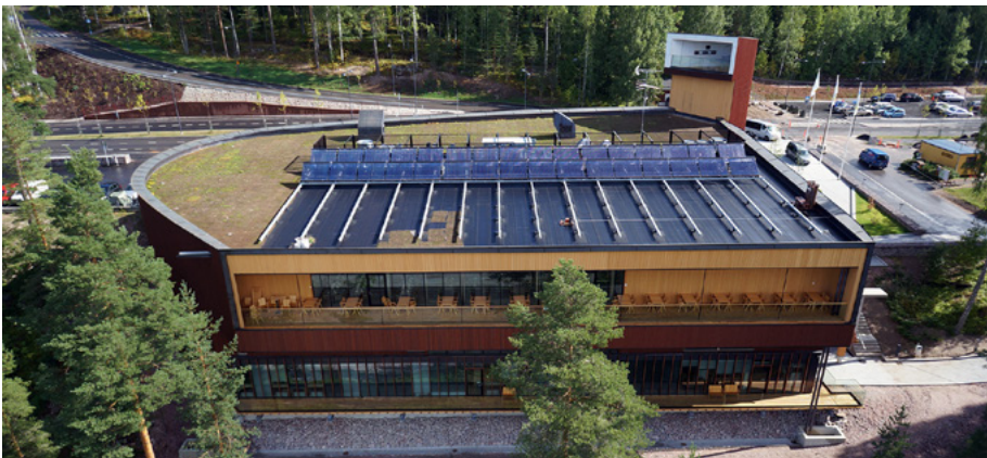
Fig. 7.48. Solar panels on the roof (Kuvataivas, n.d.).
