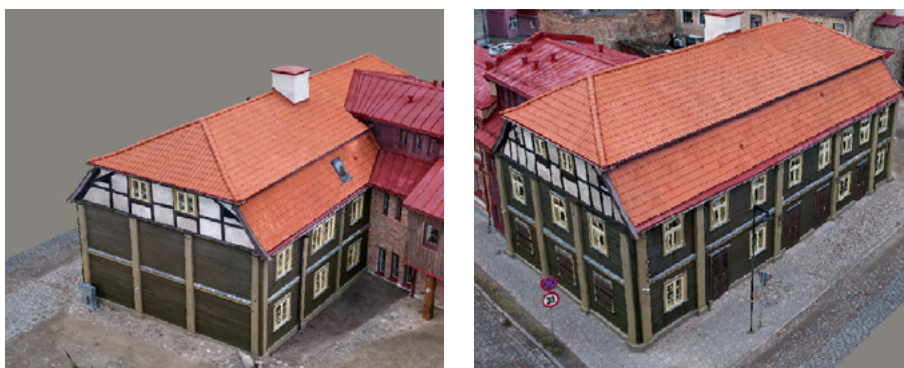
Fig. 6.12. 3D reality model after renovation process (Jelgavas Vecpilsētas ēku pārbūve, restaurācija, 2020; Tehnoloģiju pieskāriens vēsturei, 2020; Jelgava old city, 2020).
