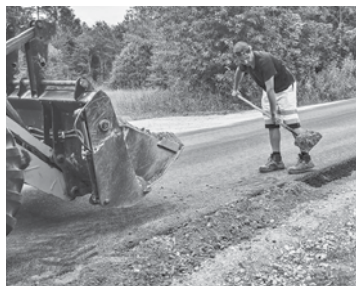
SIA A Land ceļu būves palīgstrādnieks Valters Priekškalns apber asfaltētā ceļa malas.
