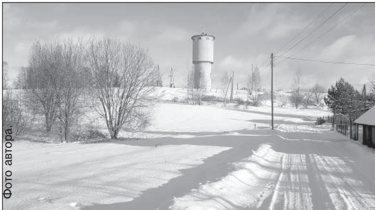
Водонапорная башня Пискуновка со стороны Лиелие Гаранчи (2019).
