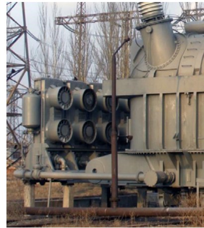
3.25. attēls. Piespiedu gaisa un piespiedu eļļas cirkulācijas sistēma: 1 – tvertne; 2 – magnētqvads ar tinumiem; 3 – elektrosūkknis; 4 – radiatori; 5 – ventilatori
