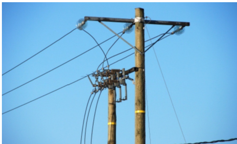
5.37. attēls. GVL pārsprieguma aizsardzība ar izlādņiem
