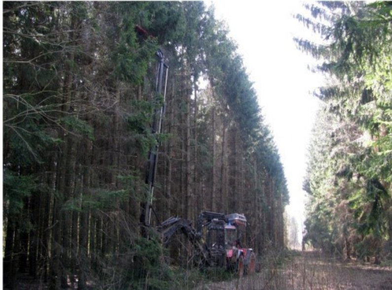
4.17. attēls. 20 kV GVL trases vertikālā zaru apzāgēšana
